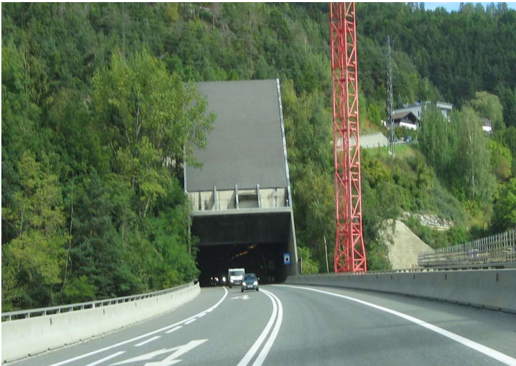
Abb. 1: Die Verteilung der Feuchte in den Innenschalen von Verkehrstunnels ist noch weitgehend unbekannt.
