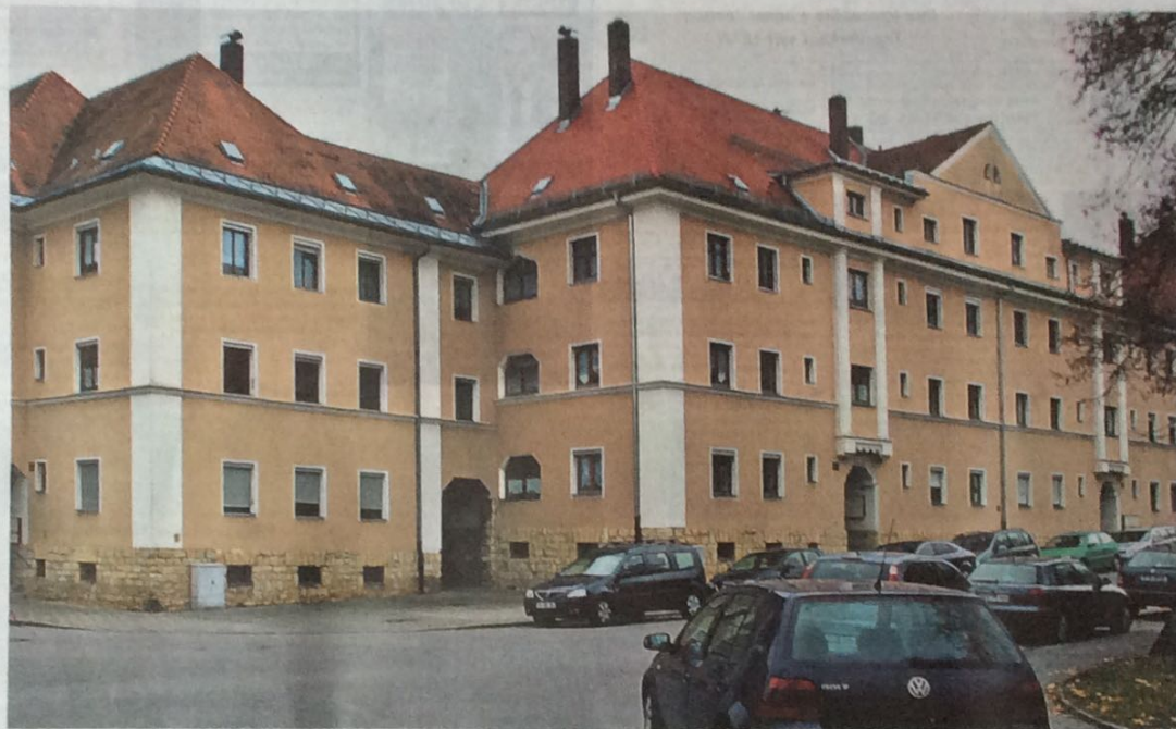
Die Plato-Wild-Siedlung, ein genossenschaftliches Projekt, wurde zwischen 1912 und 1926 gebaut. Nun wurde es energetisch saniert.
