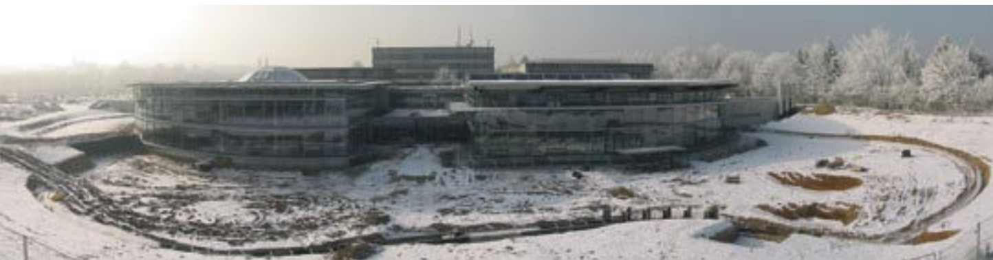
Vereist, verschneit und von allen Bauarbeitern verlassen: Während des strengen Winterwetters im Februar 2006 ruht die Baustelle für einige Tage. (Foto: Hochmuth)
