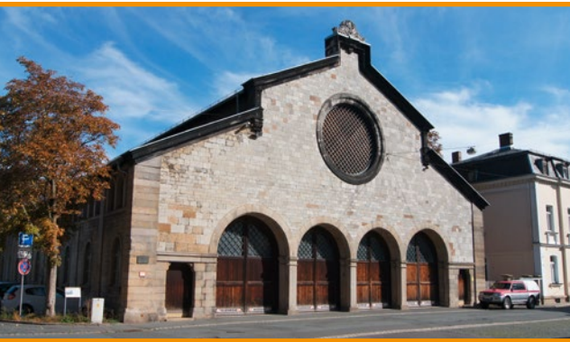
Einsteighalle in Hof — Bild: Anja Säbel
