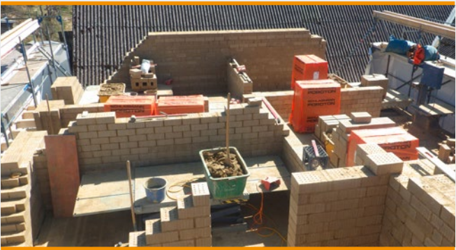
Tragende Lehmsteinwände — Bild: Florian Bielmeier
