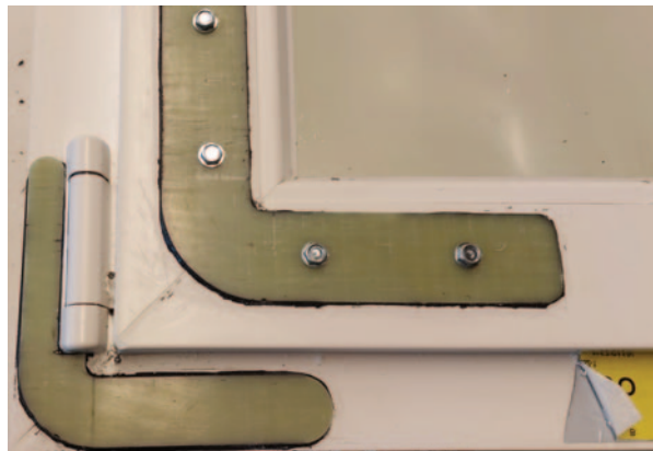
Patches aus glasfaserverstärktem Duroplast nach Klebstoffanbringung an den Fensterrahmen; Fotos: Andreas Kastenmeier
