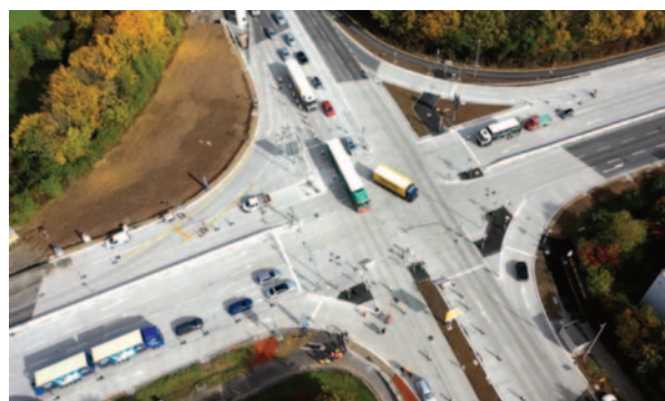
Knotenpunkt in Betonbauweise. Foto: Alexander Grünwald
