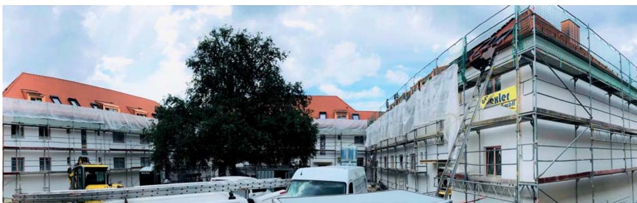
Baustelle am 19. Juni 2020 – Die Gebäudehülle mit dem neuen Putzsystem des Konsortialpartners Franken Maxit Mauermörtel GmbH & Co. sowie der Dachgeschossausbau für mehr günstigen Wohnraum sind kurz vor dem Abschluss. Die Photovoltaikanlage wird gerade auf dem Westflügel montiert. Foto: Dr. Michael Riederer
