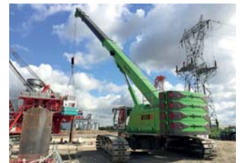
Ein Teleskopkran im Einsatz: SENNEBOGEN 6113E bei einer Großbaustelle in Paris
