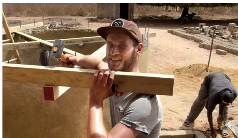
Bau der Dachkonstruktion durch Andreas Geier
