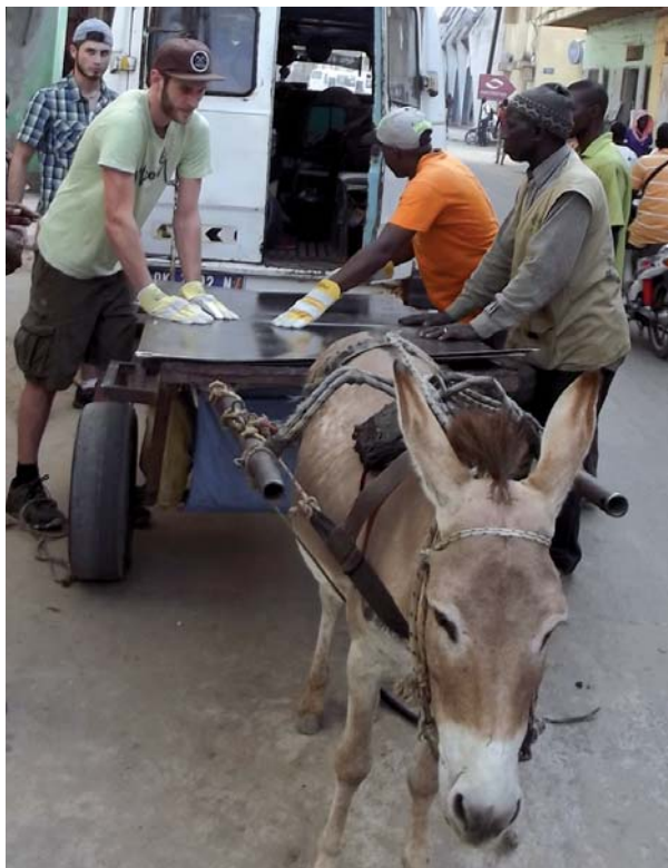
Verladen der Baumaterialien der Regenwasserzisterne in Ziguinchor durch Ibou Goudiaby, Repräsentant Kinderhilfe, Markus Schmidt, Andreas Geier und andere Helfer. Fotos: privat
