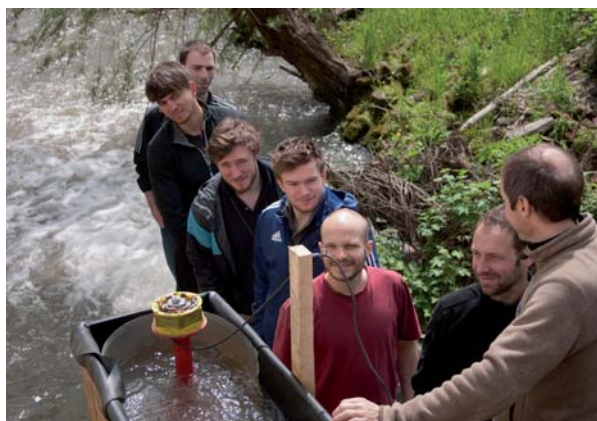
Die installierte Turbine an der kleinen Labe. Foto: H. Köhler
