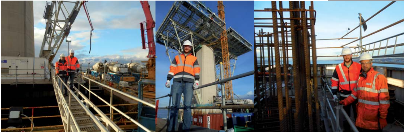
Dipl.-Ing. Christian Niemietz und Quirin Strobl auf der Brückenbaustelle über den „Firth of Forth“. Fotos: Quirin Strobl
