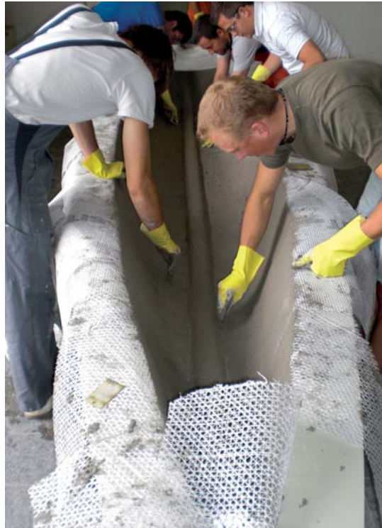
Team der Bauingenieure beim Einspachteln der optimierten Betonmischung in die Schalung als Negativform.
