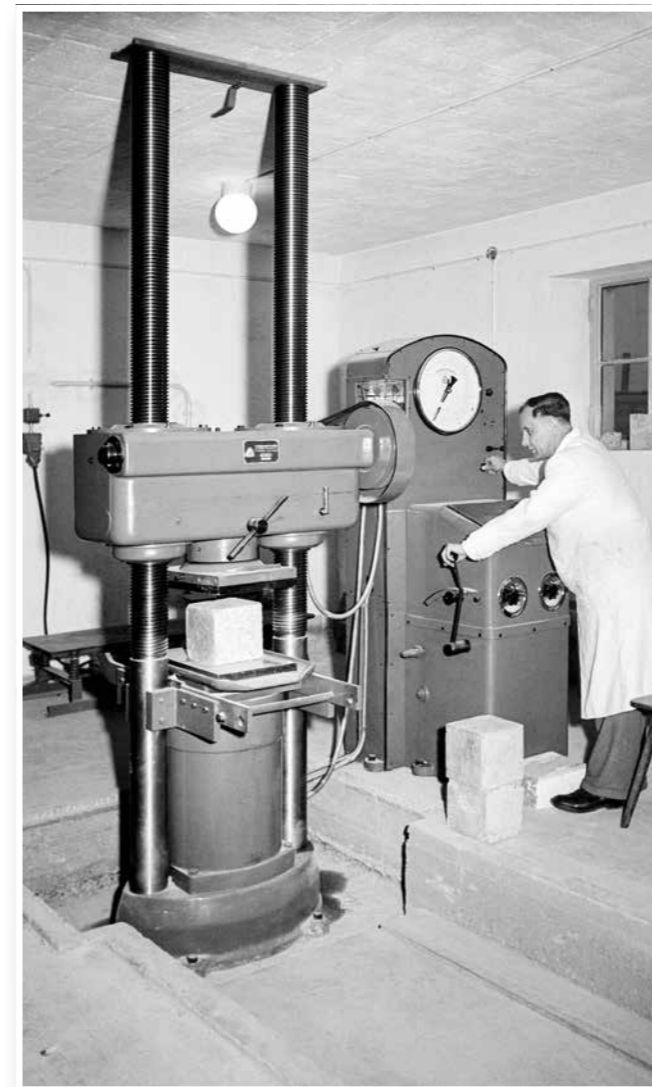
Der Praxisbezug in der Lehre war von Beginn an verankert - etwa bei der Arbeit am Betonprüfstand.
