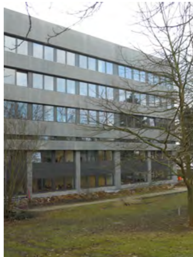
Fassadensanierung Seminargebäude Seybothstraße, Nordfassade
