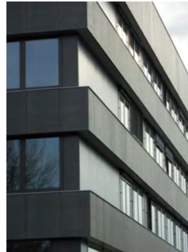
Fassadensanierung Seminargebäude Seybothstraße, Detail
