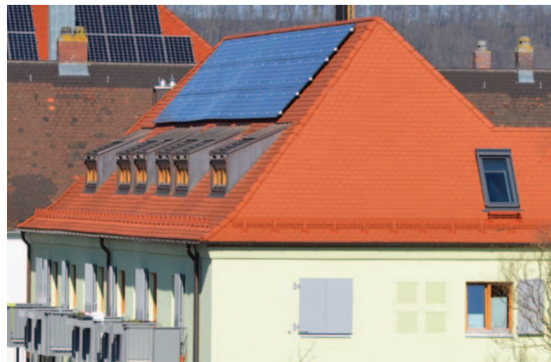
Abbildung 1: Am Demonstrationsgebäude in der Margaretenau wurde ein Solarselektives Wärmedämmsystem eingebaut. (Foto: OTH Regensburg)
