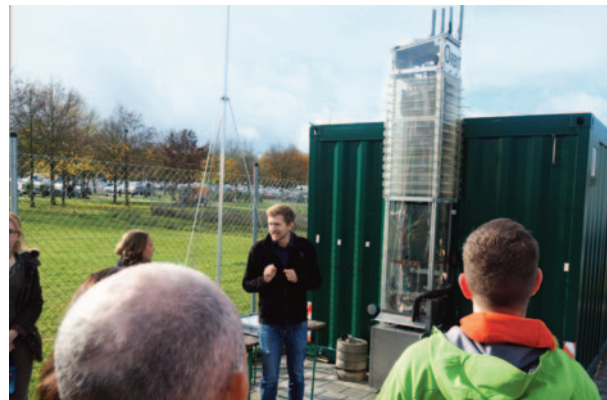
FENES-Mitarbeiter Michael Heberl erläutert die grundlegende Funktionsweise der Methanisierung und erklärt, wie diese an der Methanisierungsanlage umgesetzt wurde.
