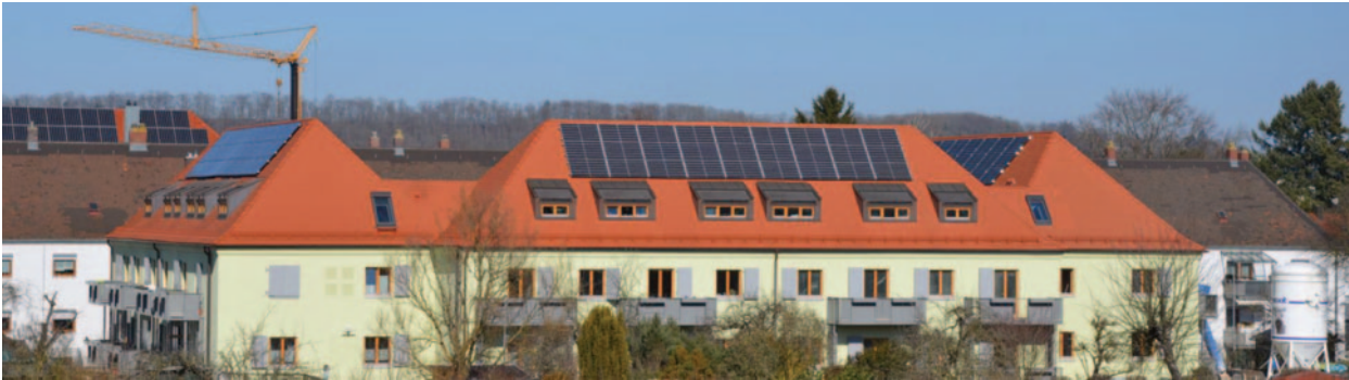
Abbildung 3: Diese Außenansicht zeigt das Demonstrationsobjekt nach der Sanierung. (Foto: OTH Regensburg)
