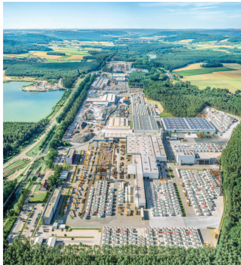
Panoramaaufnahme des gesamten Industriegeländes der Firma Max Bögl mit Blick auf Sengenthal (Vordergrund), Neumarkt in der Oberpfalz (Hintergrund) und den Windenergieanlagen in nordöstlicher Richtung. Foto: Firmengruppe Max Bögl
